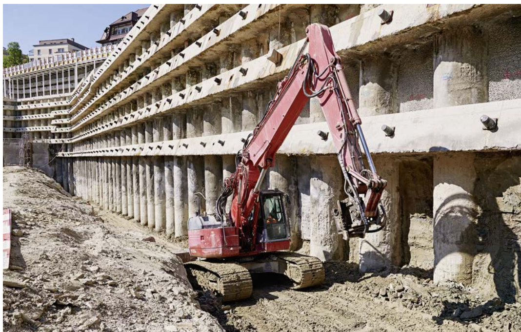
Ein Bagger im Einsatz auf der Baustelle Hirschenpark. Platz ist hier genügend vorhanden. (Foto: Sam Bosshard)
