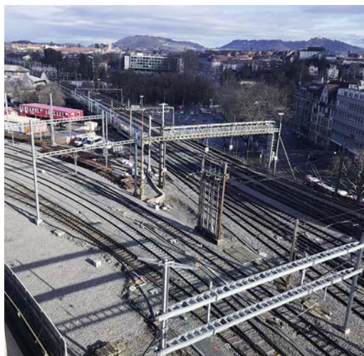
Der «Betondeckel» im Eilgut mit den bereits darüber verlegten Gleisen.
