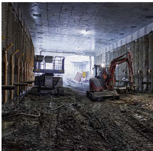
Die «versteckten» Aushubarbeiten unterhalb des Areals.
