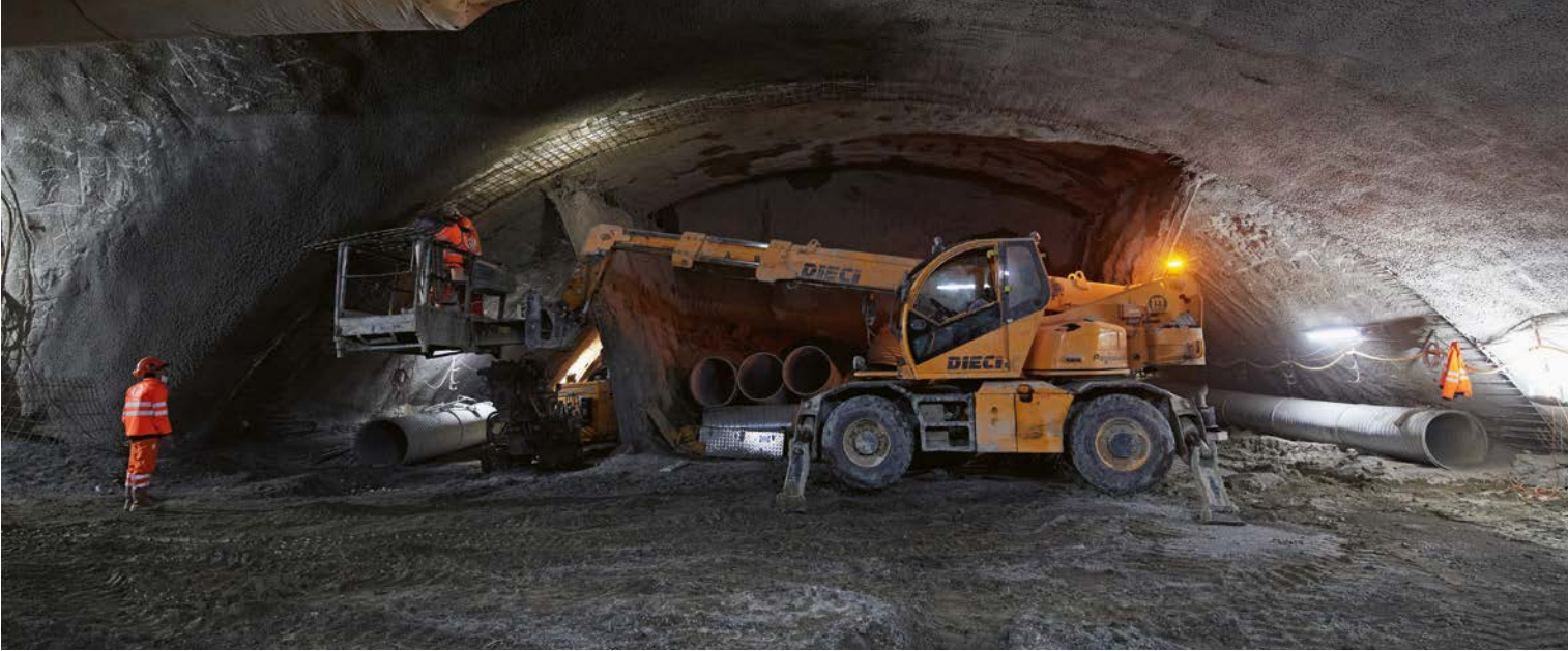
Hier entsteht eine der beiden Kavernen des künftigen RBS-Bahnhofs Bern. (Foto: Sam Bosshard)
