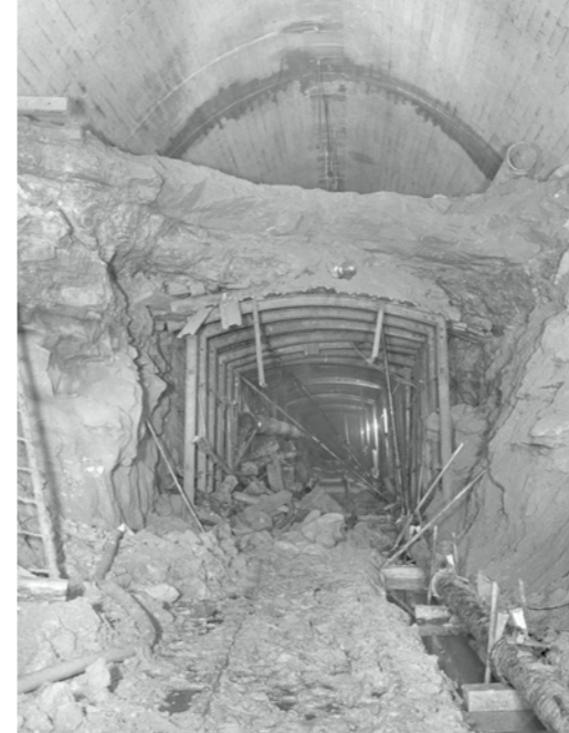
Tunnelbauarbeiten in den 60er-Jahren.
