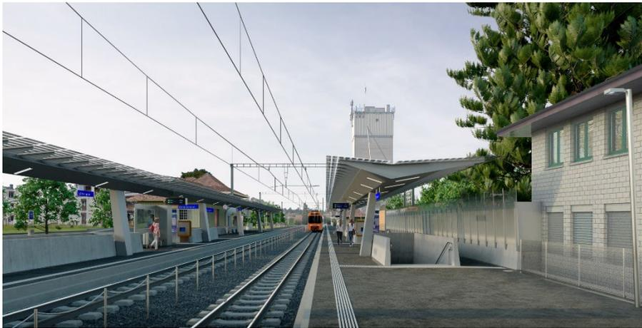
Blick Richtung Bern: Links das bestehende Bahnhofgebäude, rechts das neue Aussenperron mit zwei Aufgängen, einem Wartehäuschen, einer Sichtschutzwand zum Bubenbergquartier hin und einem neuen Perrondach mit integrierter Photovoltaikanlage.
