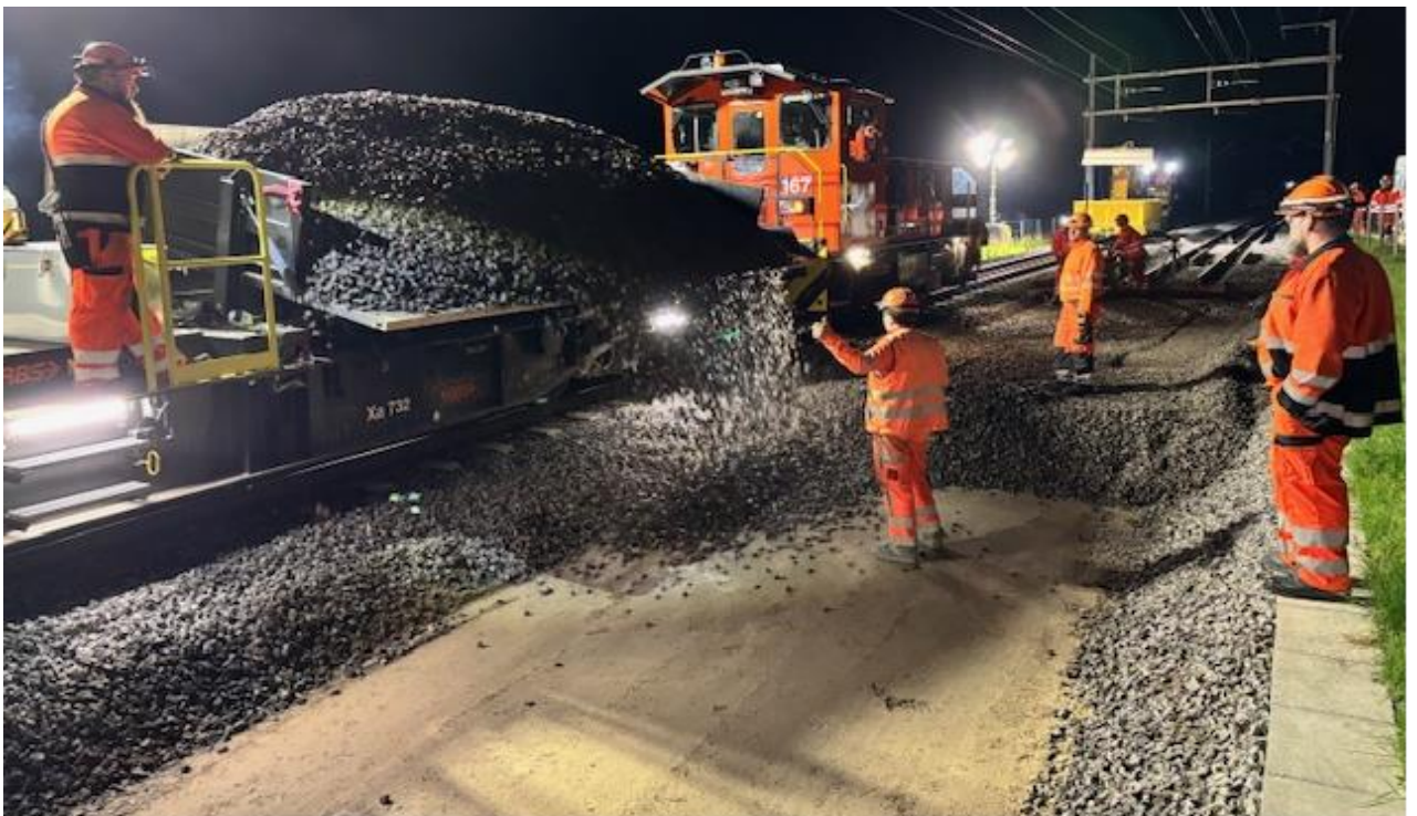
Büren zum Hof; Unterbausanierung 14.04.2025
