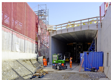
Das Südportal der neuen RBS-Unterführung.
