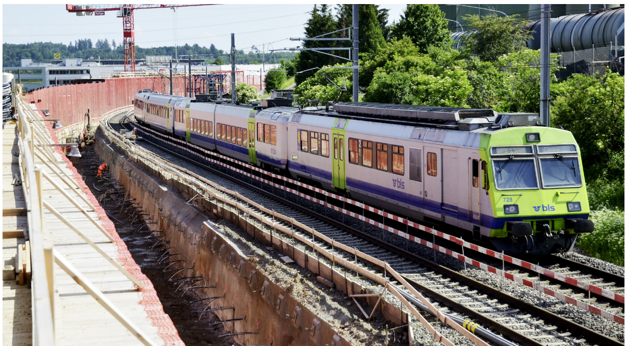
Unter engsten Verhältnissen muss die Stützmauer zwischen den Gleisen des RBS und der SBB erstellt werden. Der RBS verkehrt im Bereich des Krans unter dem Schutztunnel (links), während das nähere Gleis der SBB bis Anfang Dezember 2018 gesperrt bleibt.
