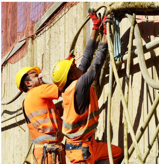
Montage der Zuleitungen (Luft, Zement, Strom) für das Bohrgerät entlang des Schutztunnels des RBS.
