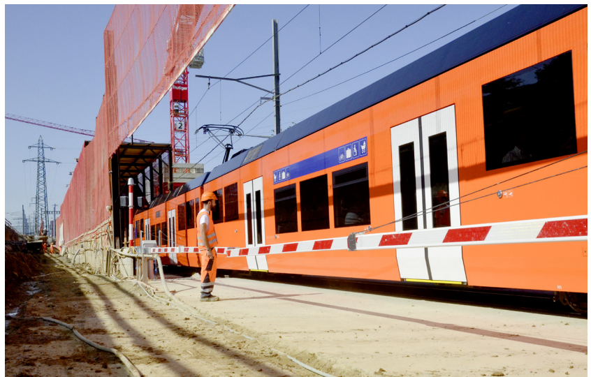
Ein eigens erstellter Bahnübergang mit Vollschranken ermöglicht die sichere und direkte Zufahrt zur Baustelle zwischen SBB- und RBS-Gleis.
