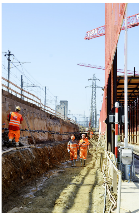
Facharbeiter kontrollieren Lage und Höhe der bereits gesetzten Anker bei der Baugrube.
