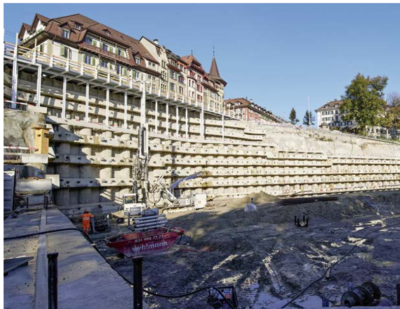
Blick zur Baugrube Hirschenpark mit ihrer markanten Bohrpfehlwand.
